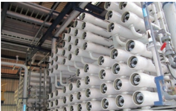
廢水回收技術-薄膜(RO)設備
