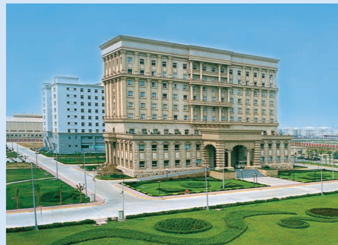
台塑關係企業寧波工業園區 FPG Ningbo Industrial Park
