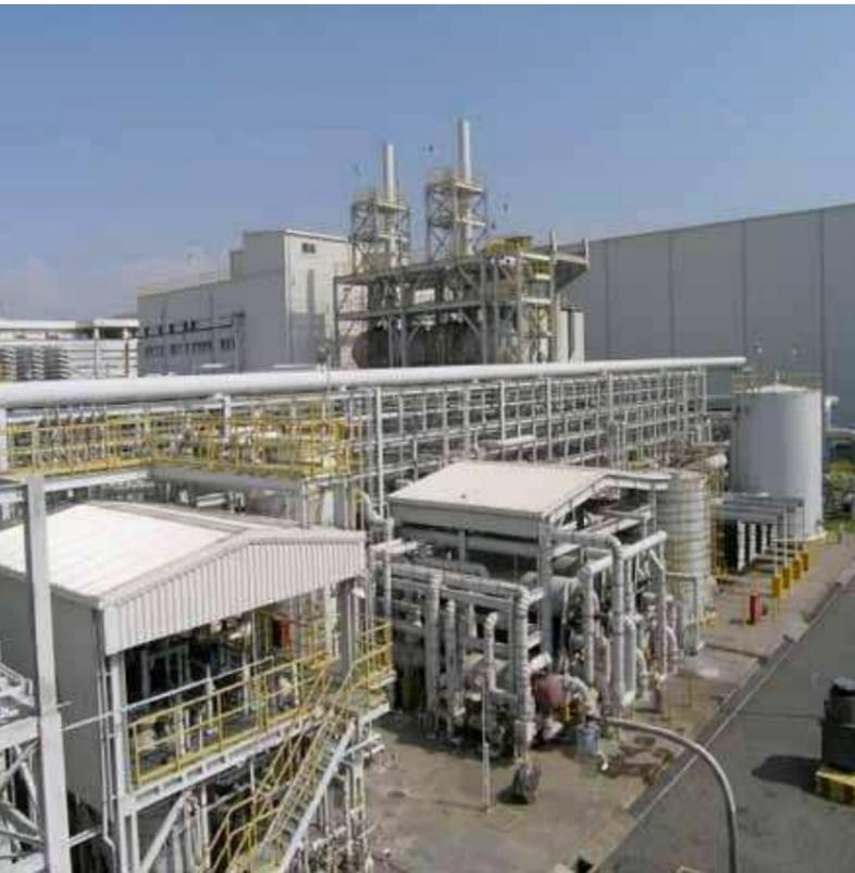
台塑烯低密度聚乙烯 (LDPE) 採用 Enichem 高壓製程技術生產，此製程包含管式法及槽式法。
