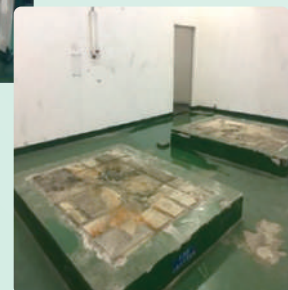
NF 3 罐裝區管線設備拆除
