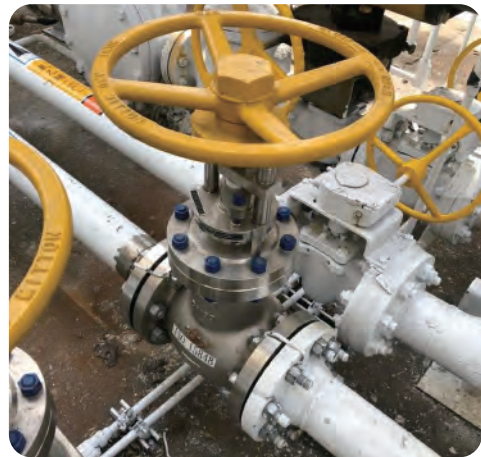
低洩漏型及元件精簡型閥門
