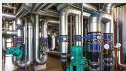
設備用電與溫度監測
