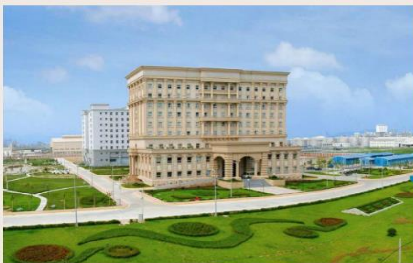
台塑企業寧波工業園區 FPG Ningbo Industrial Park
